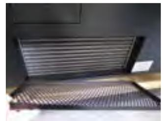
**Schutzgitter des Kondensators kann ohne Werkzeuge zur einfachen Reinigung geöffnet werden**
